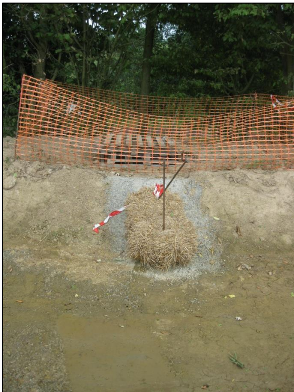
Figure 23 : Emplacement du filtre à particules fines (botte de paille) pendant la phase des travaux au niveau du bassin d'orage
